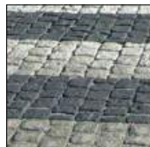
PŘECHOD PRO CHODCE KOMBINACE TMAVÉ A SVĚTLÉ ŽULOVÉ DLAŽBY (10x10 mm)
